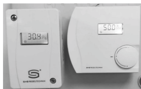
Figure C : Mesure et affichage de la surpression (30,4 Pa) de l'air et l'humidité (50,0%) dans la salle blanche.
